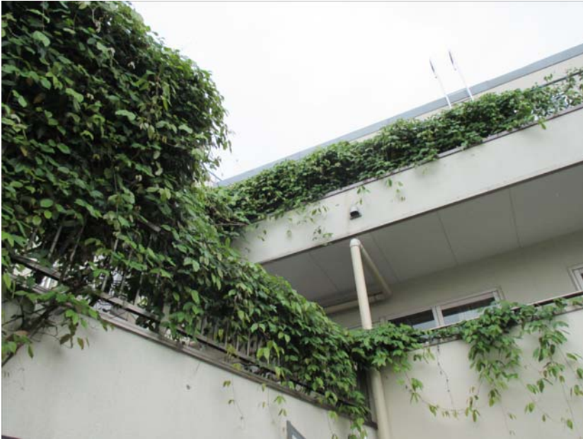
<10> 工事名称：アイラトピカズラ工法壁面緑化 建物名称：医療法人社団河北前田病院 施工内容：植付から3年目30m以上成長 両サイド 手摺部分に分岐し成長続けている。 撮影日：2014-04-29
