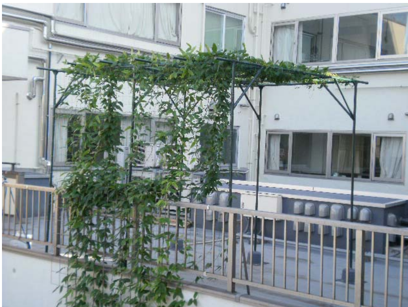
<6> 工事名称：アイラトピカズラ工法壁面緑化 建物名称：医療法人社団河北前田病院 施工内容：植付から12ヶ月目14m以上の成長 撮影日：2012-10-15
