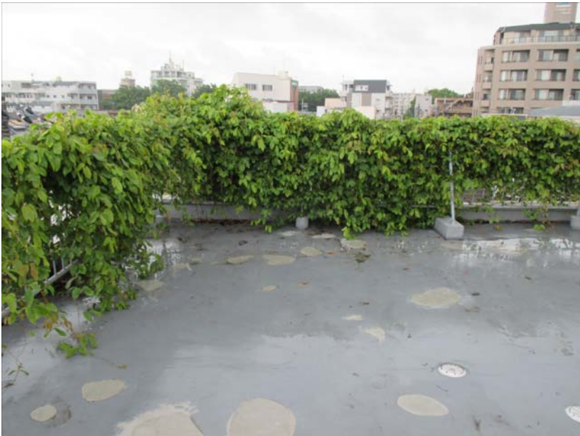
<11> 工事名称：アイラトピカズラ工法壁面緑化 建物名称：医療法人社団河北前田病院 施工内容：植付から3年目30m以上成長 両サイド 手摺部分に分岐し成長続けている。 撮影日：2014-04-29
