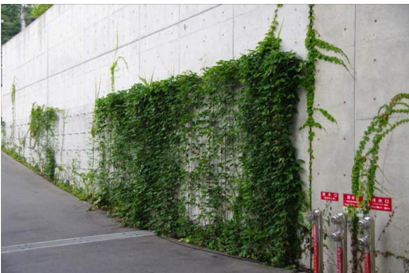
<6> 工事名称 ：安藤事務所設計海星病院壁面緑化 建物名称 ：海星病院 撮影日 ：2010年7月5日 施工内容 ：2年経過 コメント ：水分の行き渡る所では成長早い。
