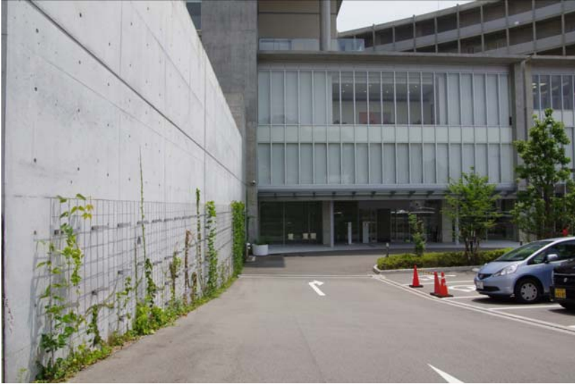
<4> 工事名称 ：安藤事務所設計海星病院壁面緑化 建物名称 ：海星病院 撮影日 ：2010年7月10日 施工内容 ：1年経過 成長が速い部分は3mの頂上に達している。
