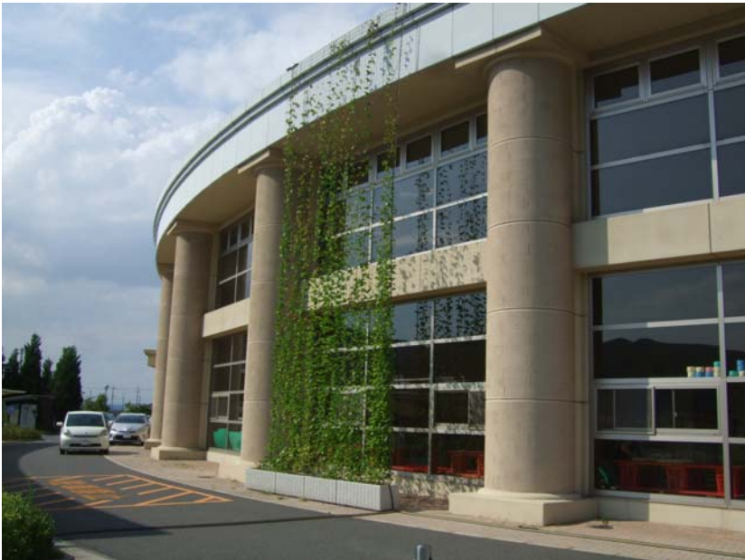
<5> 工事名称：岡山市都市整備局発注緑のカーテン2箇所 建物名称：岡山市営老人ホーム 撮影日：2014年8月19日 施工内容：3ヶ月経過 H：12000mm の頂上に到達 コメント：3ヶ月で夏季の日差しを遮ることが出来た。
