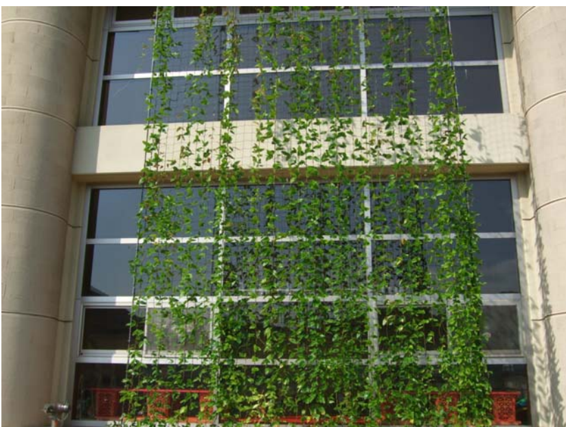
<6> 工事名称：岡山市都市整備局発注緑のカーテン2箇所 建物名称：岡山市営老人ホーム 撮影日：2014年8月19日 施工内容：3ヶ月経過 H：12000mm の頂上に到達
