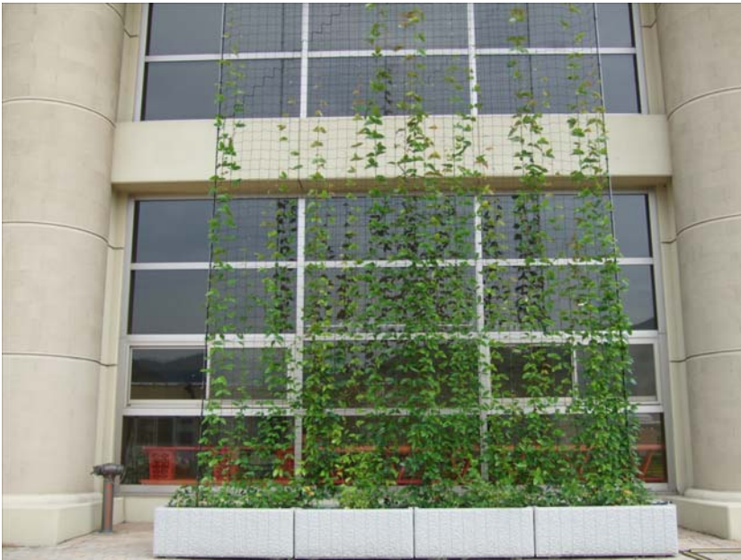
<4> 工事名称：岡山市都市整備局発注緑のカーテン2箇所 建物名称：岡山市営老人ホーム 撮影日：2014年7月17日 施工内容：2ヶ月経過 H：8000mm
